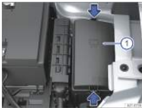
Fig. 225 En el vano delantero: caja de fusibles.
